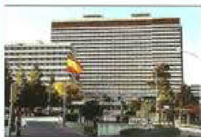
HOSPITAL CENTRAL DE LA DEFENSA
