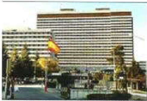
HOSPITAL CENTRAL DE LA DEFENSA
